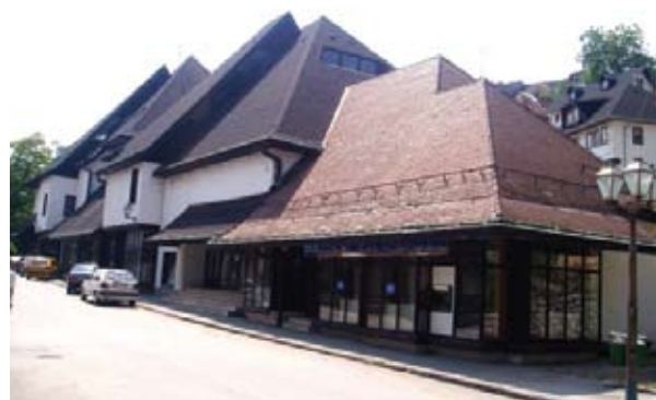
Sl. 6 – Robna kuća u Jajcu Illus. 6 – Robna kuća in Jajce
