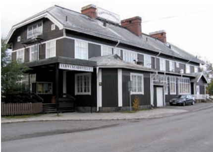
Järnvägshotellet från 1903, efter ritningar av Folke Zettervall, är en karaktärsbyggnad på stationsområdet som genom åren fyllt en viktig funktion som hotell och mötesplats i Kiruna. Järnvägshotellet är ett av få i landet som uppfördes av SJ och av nationellt intresse.
