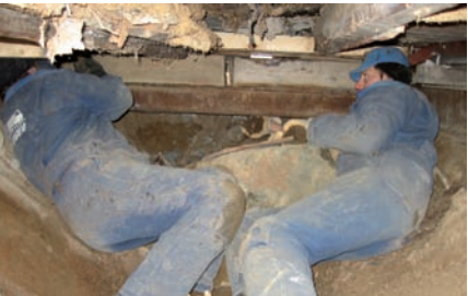
Provisoriska stålbalkar monteras under bärande väggar. Foto: Nya Töre Husflytt AB
