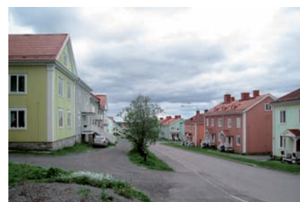
Bostadshusen i Thuleområdet är väl sammanhållna 1920-talskvarter uppförda av LKAB och fina exempel på tidigt flerbostadsbyggande inom stadsplanen.
