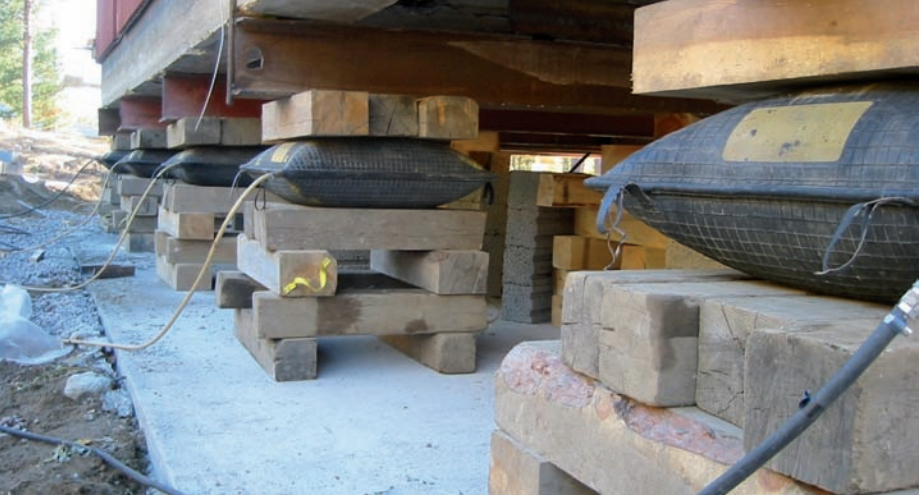
Lyftkuddar behöver endast några få centimeters utrymme. Kuddarna lyfter synkroniserat, och ytterligare pallning monteras steg för steg. Foto: Nya Töre Husflytt AB
