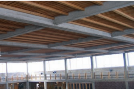
Betongstommen återuppbyggs på ny plats efter ursprungliga ritningar. Takbalken, en betongklädd stål balk är 1,1 x 0,3 meter med en spännvidd på 22,5 meter
