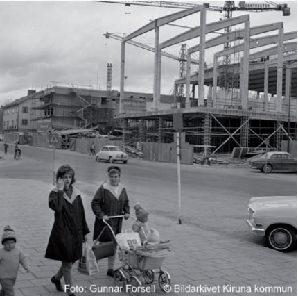
Sporthallen under uppförande 1950-60 tal. Foto: Gunnar Forsell © Kiruna kommun.
