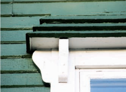
Bevarad fasaddetalj ovan fönster på Bläckhorn med brutet tak.
