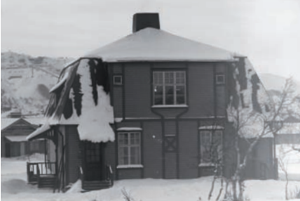
Bläckhornens ursprungliga exteriör: Förlorad fasadutsmyckning med lister, tillsammans med fönster som byttes ut och förminskades i samband med ombyggnad på 40-talet. Fotograf Thorsten Dahllöf, Kiruna.
