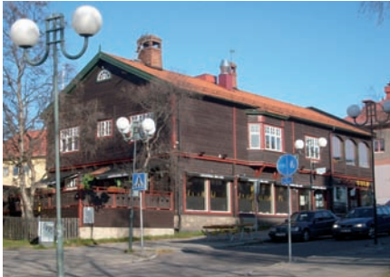
Butiks- och bostadshuset uppfört 1911 efter ritningar av Folke Hedman. Ett av äldre bevarade butikshus i Kiruna centrum. Byggnaden har genom tiderna inrymt olika butiker och är fortfarande idag med sin restaurangverksamhet en plats för sociala möten.
