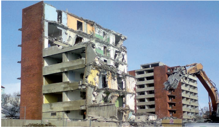
Våren 2010 startade rivningen av de tre kallställda husen på Terrassen. Foto: Curt Persson.
