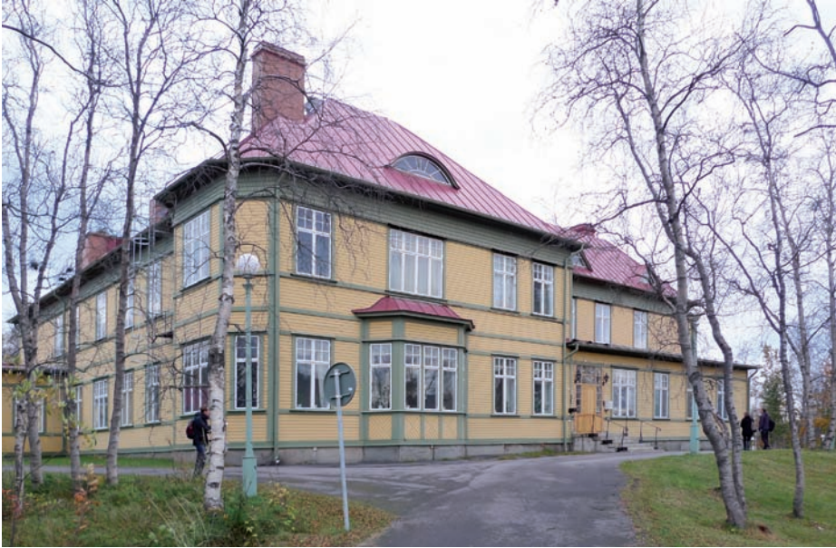
Bolagshotellet uppfördes 1901 efter ritningar av Gustaf Wickman. Han inspirerades av tidens amerikanska "shingle style" och utformade byggnaden med branta, nedtill svängda takfall och rikt artikulerade fasader. Bolagshotellet har ända sedan byggnadstiden använts som representativ inkvartering för LKAB:s gäster. Byggnaden är en symbol för gruvbolaget och av nationellt intresse.
