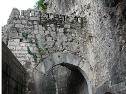
Bristfällig avkröning och sprickor
