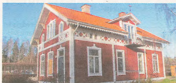
Stationshuset i Ornäs måste omedelbart flyttas och rustas om det ska finnas kvar.
