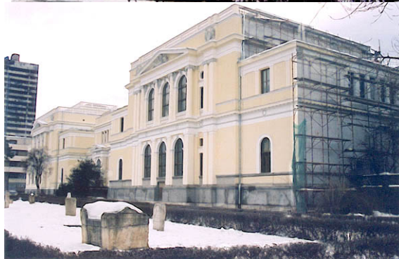
Restaureringsarbetena är nästan klara. Foto KuG, januari 2003.
