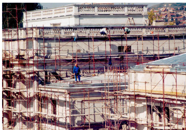
Restaureringsarbetena av fasaden i full gång. Arbetena har kunnat genomföras med hjälp av bidrag från Sida. Foto Miodrag-Dragan Radovanovic, september 2002.
