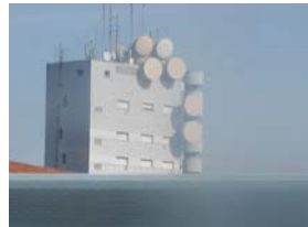
Tornhus vid viadukten
