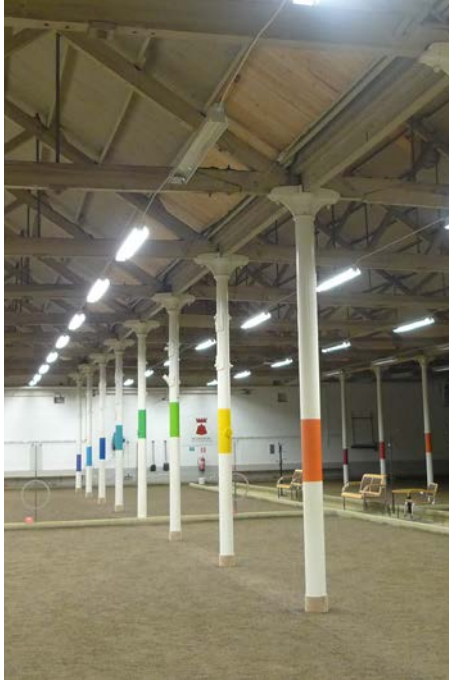
Interiör från den före detta Jutevävsfabriken. De ursprungliga gjutjärnskolonnerna bär ännu byggnadens tak.
