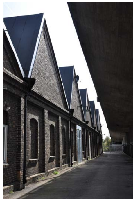
Jutfabriken ligger i nära anslutning till Viadukten.
