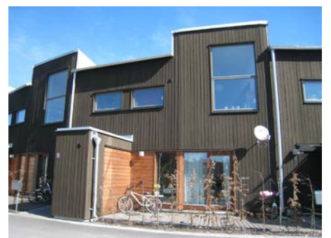
Exempel på 2000-talets cirkelformade radbus
