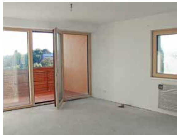
Figur 5 Muhlweg i Wien av Dietrich & Untertrifaller, passivhus med mindre fönster generellt men stora partier mot balkongerna. Därmed hindras värme-läckage via strålning nattetid.
