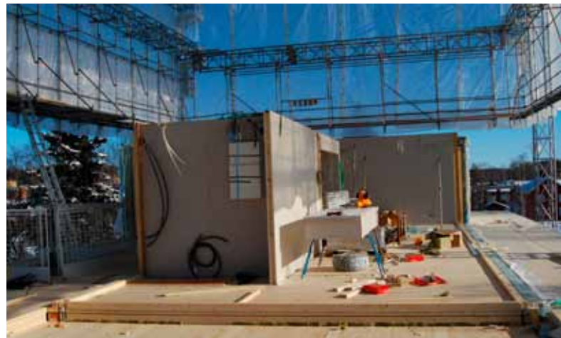
Figur 7 Köks- och badrumsvolymer monterade på ett våningsplan i hus med bärande planelement.
