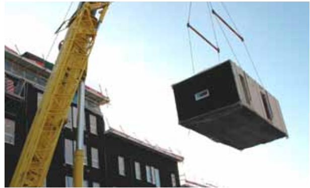
Figur 18 Montage av volymelement.
