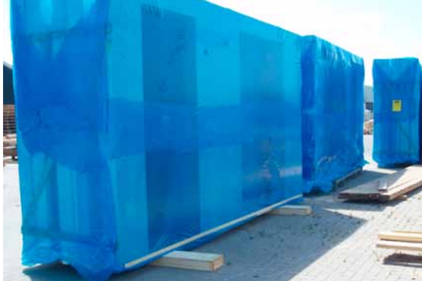
Figur 36 Vädertskyddade väggelement färdiga för leverans.
