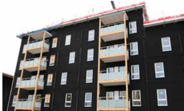
Figur 20 Femvåningshus uppbyggt med volymelement med bärande KL-skivor.
