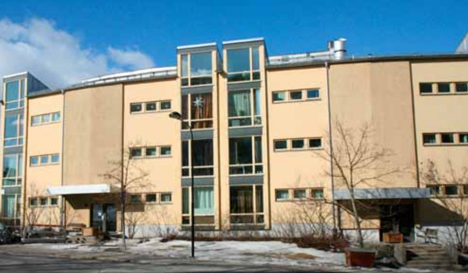
Figur 25 Exempel på putsad fasad, 3-våningshus.
